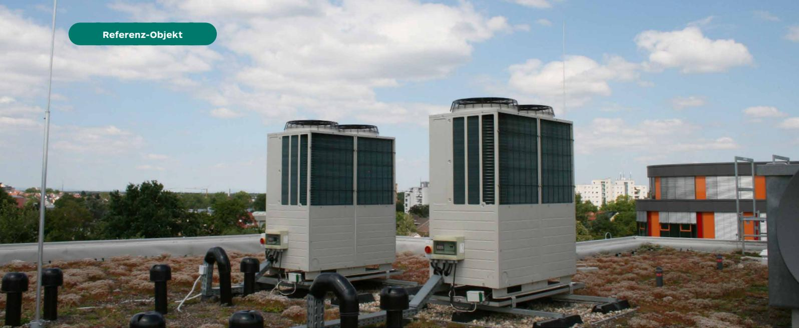
Die insgesamt 7 Außengeräte der FDC-Serie wurden auf dem Dach des Hotels installiert und in verschiedenen Kältekreisen der Ost- bzw. Westseite des Gebäudes zugewiesen. Sie wurden zudem mit Blitzschutz und Ölauffangwannen ausgestattet.
