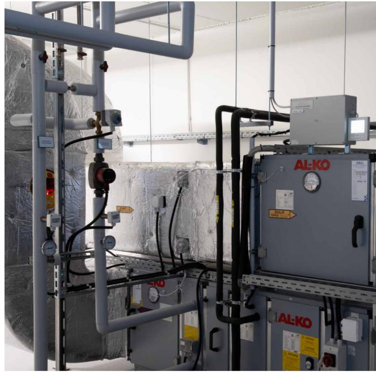
Der in der Lüftungsanlage integrierte Wärmetauscher ist mit einem Mitsubishi Heavy Industries Außengerät verbunden. Mit dem Wärmeübertrager-Anschlussmodul wird die Verknüpfung zwischen Lüftungsanlage und Klima-Außengerät hergestellt – es ist das steuertechnische Bindeglied der beiden Komponenten.
