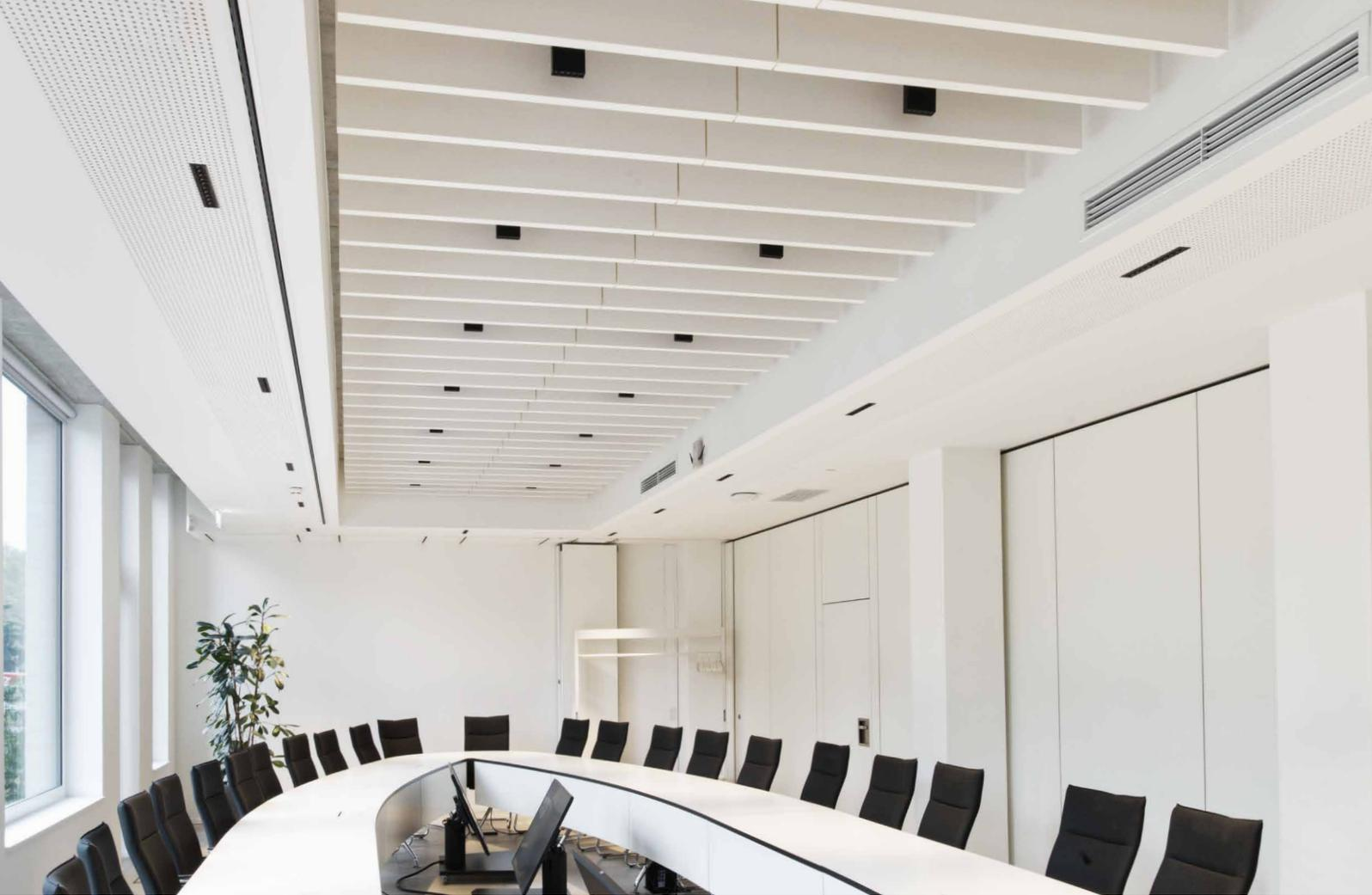
Im Konferenzraum sind die Kanalgeräte in einer abgehängten Decke verbaut, nur die Lüftungsgitter sind sichtbar.
